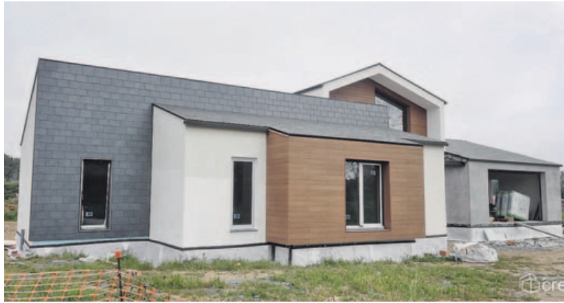
Una casa pasiva en el municipio de El Franco. La casa pasiva que se construye en El Franco (Asturias) está previsto tenerla lista y entregarla este verano. MÉTODO CREA
