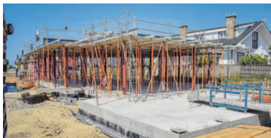
El edificio del complejo hostelero está en construcción.
