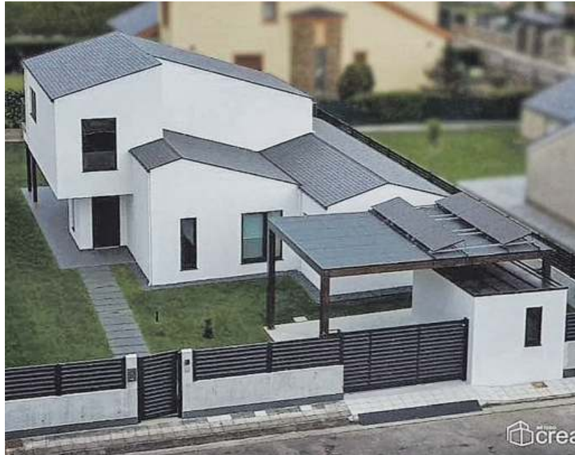
Vivienda pasiva con instalación fotovoltaica en Tapia. MÉTODO CREA
